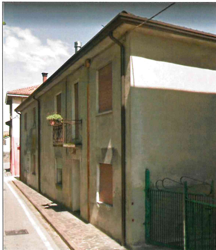
Foto da via Irti (Corpo A)
