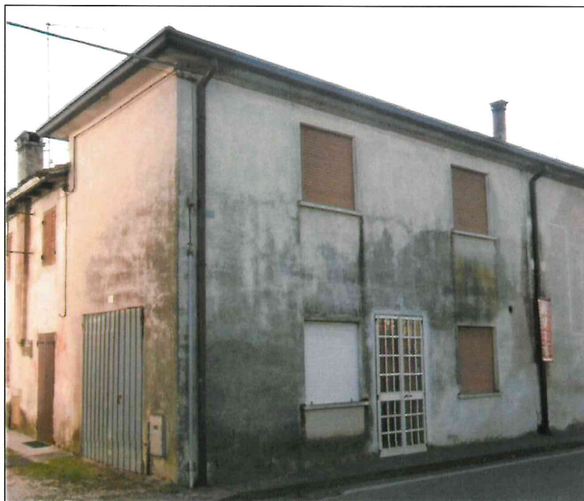
Foto da via Irti (Corpo A)
